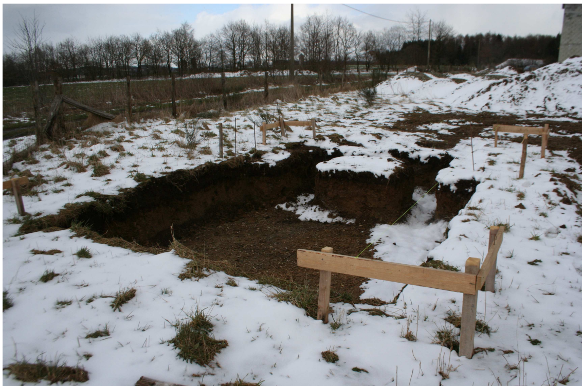
Fondations de la coupole « Ducuroir » - photo du 25/03/08
