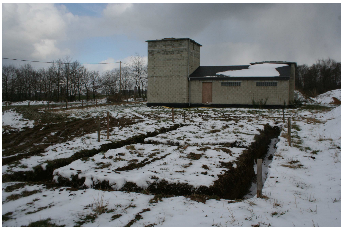
Fondations de la coupole pour personnes à mobilité réduite, avec le bâtiment principal en arrière-plan – photo du 25/03/08
