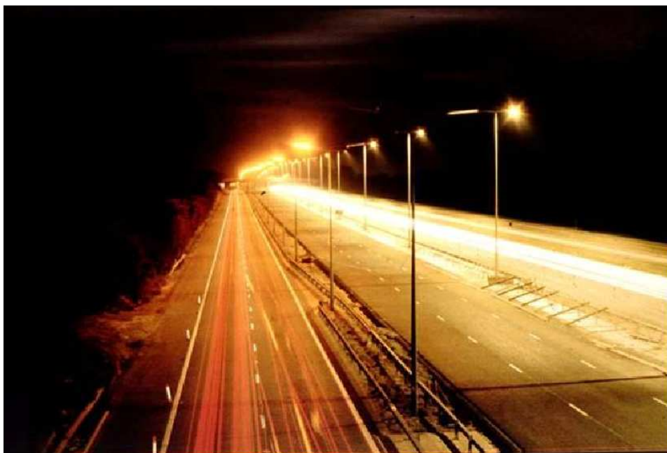
Figure 6 - lampadaires Sodium Basse Pression (à l'arrière plan) remplacé par des lampadaires Sodium Haute Pression (à l'avant plan).
