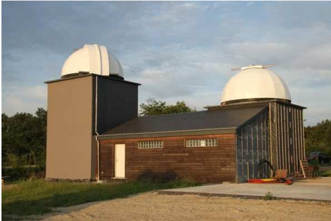
Bâtiment principal de l'OCA (Yves Chalon)
