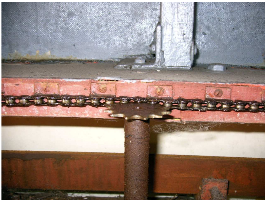
Entraînement de la rotation de la coupole par roue dentée sur chaîne de vélo
